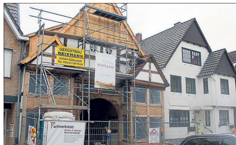
„Das Baudenkmal – Last oder Lust?“: Am 22. April wird das Thema am Fallbeispiel dieses zurzeit in Renovierung befindlichen Fachwerkhäuses aus dem Jahr 1644 an der Emsstraße behandelt. Bild: Daub
